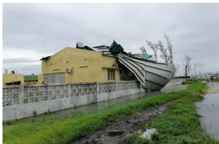
Casa del Vescovo: scopercchiato il tetto, crollati i controsoffitti, bagnati i mobili
